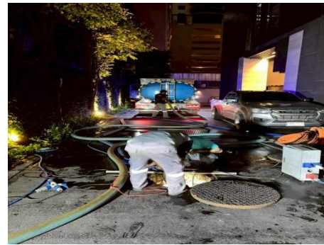
เจ้าหน้าที่สูบลึงปฏิกุลและตะกอนระบบบำบัดน้ำเสีย
